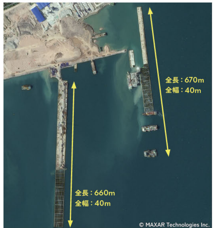
図6 建設中の栈橋2および栈橋3（2025年7月14日）
