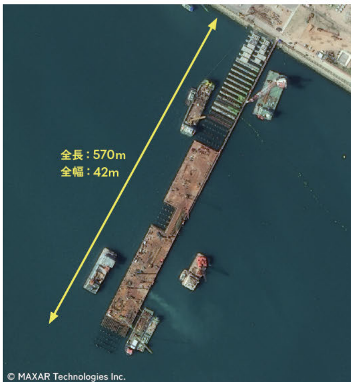
図5 建設中の栈橋1（2025年7月14日）
