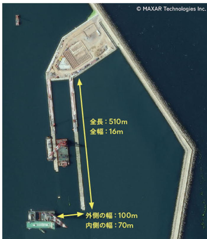
図10 建設中の消磁施設 (2025年7月14日)
