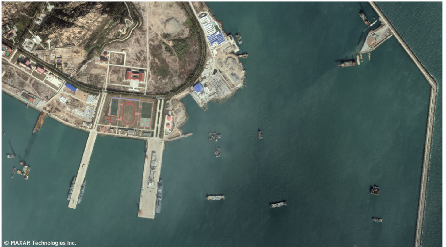
図 12 新しい棧橋等の建設を開始した青島総合保障基地 (2024 年 11 月 17 日)
