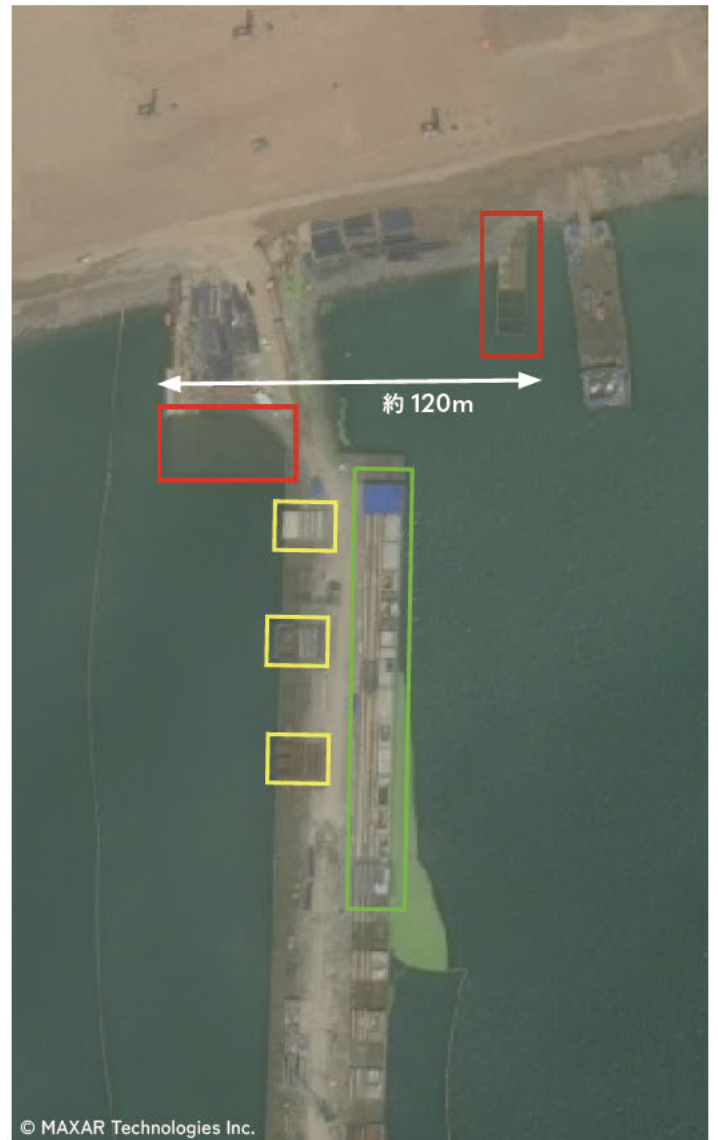
図8 建設中の栈橋2の建設状況（2025年7月26日）
